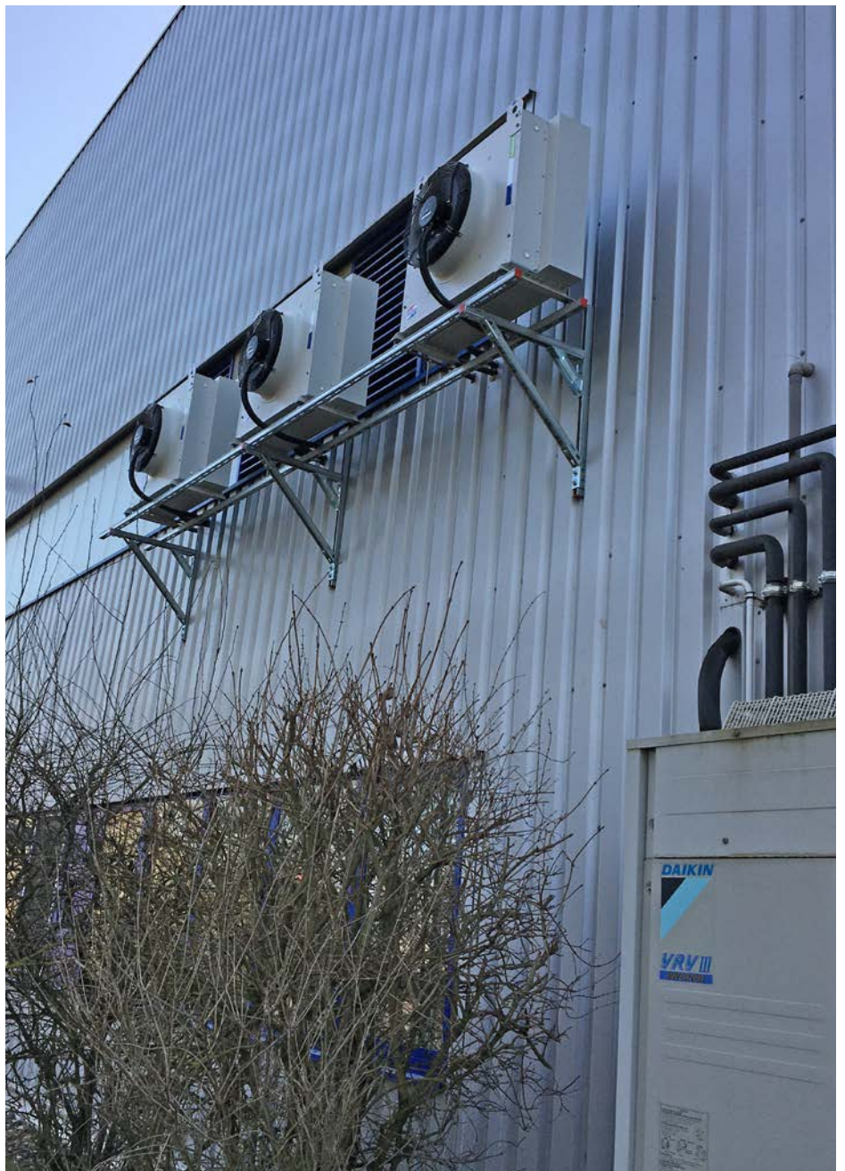
Die Verflüssiger konnten direkt an der Außenwand des Maschinenraums montiert werden.
