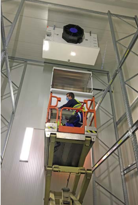
Montage der Ansaughauben
