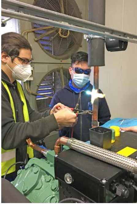
Anschluss der Verdichter durch Anhdudc Dinh
