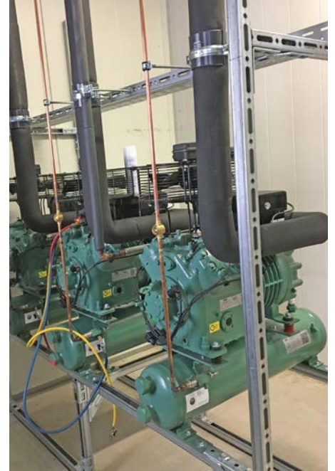
Die neue Kälteanlage nimmt Gestalt an.
