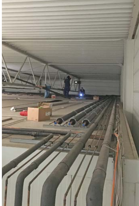
Montage von Leitungen und Rohren auf dem TK-Lager
