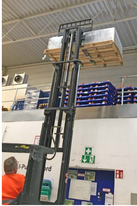
Maßarbeit ist gefragt beim Transport des Schaltschranks, Finn Karlein (oben)
