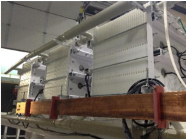
Energiespeichereinheit für Redox-Flow-Batterien
